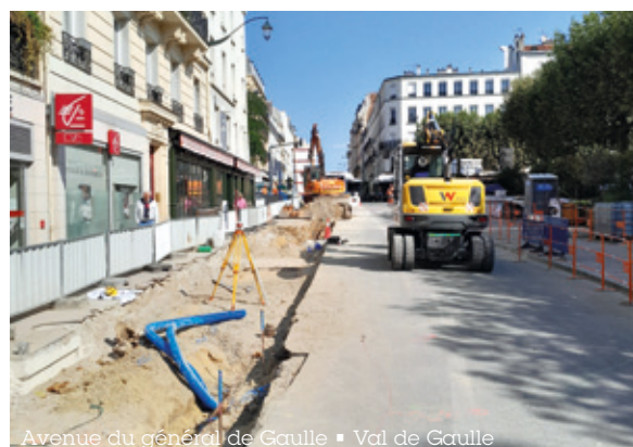
Avenue du général de Gaulle ■ Val de Gaulle
