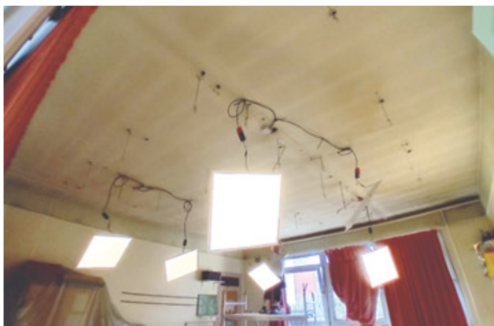
Pendant Les Travaux
