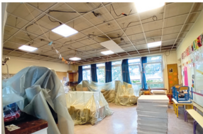
Pendant Les Travaux
